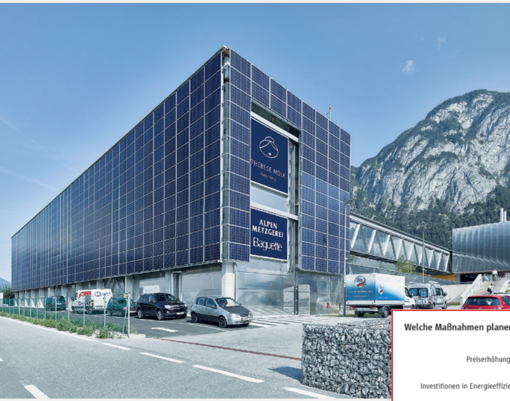
IE FOOD Projekt für MPPreis in Völs, Großbäckerei in Verbindung mit Logistik-TK-Hochregallager. Optimale Verbindung direkter Nutzung der aus PV erzeugten Energie in der Industriekälteanlage (Foto: IE Food)
