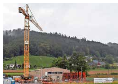
Die Baustelle der Canexis Pharma AG, südwestlich von Schlattingen.
