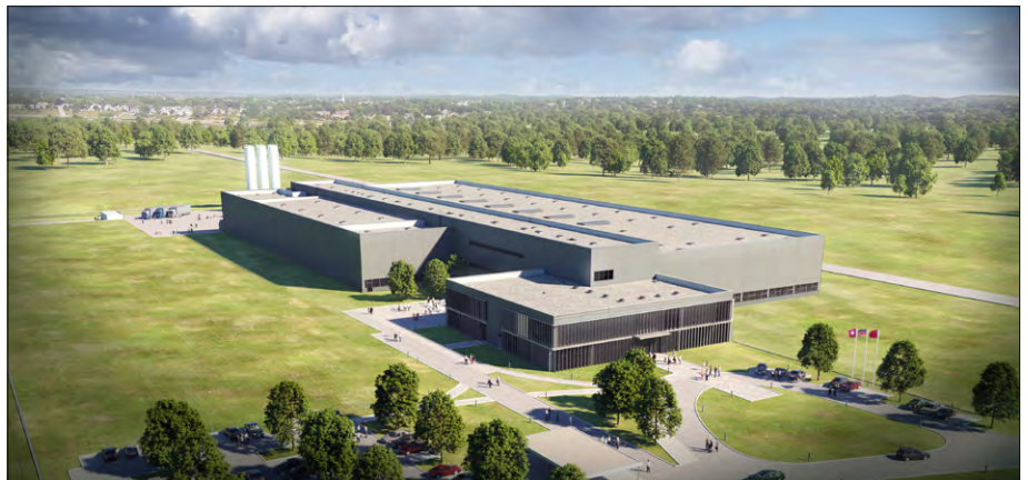
Abbildung 1: Die Entwicklung eines Masterplans vereinfacht sich signifikant, wenn grosszügig bemessene Arealflächen zur Verfügung stehen. Dieses Ideal wurde bei der Planung des Produktionswerks Ypsomed in Schwerin (Mecklenburg-Vorpommern) verwirklicht. (Bilder: IE Plast)
