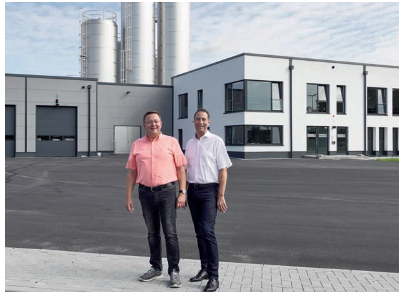
Geschäftsführer Ulrich Lembcke (links) und Harald Jakob, Leiter der Betriebsplanung bei IE Food, haben den Neubau der Meierei Viöl in kürzester Zeit gemeinsam realisiert (Foto: IE Food)
