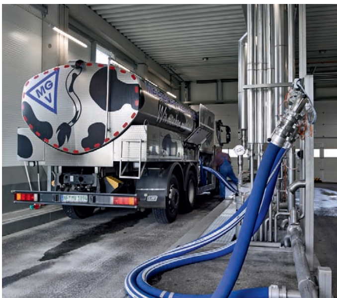
Der Stand der Technik wurde auch beim Be- und Abtanken auf drei Spuren in einer geschlossenen Halle realisiert (Foto: IE Food)
