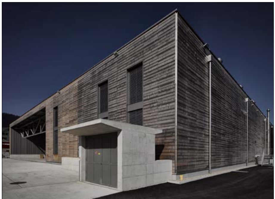
Erweiterungsbau der B. Braun Medical AG am Standort Escholzmatt (Bilder: IE Group)
