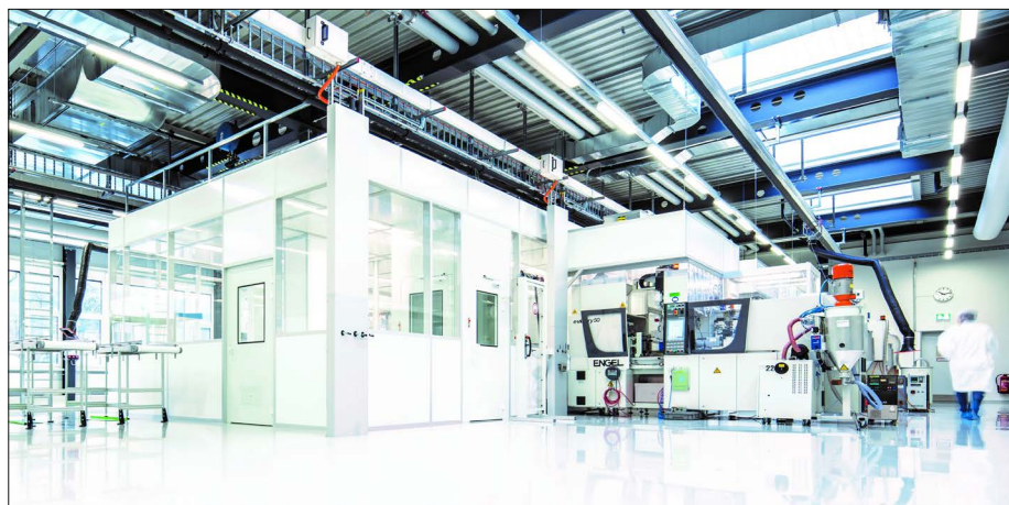
Die IE Group hat auch Know-how im Bereich der Reinraum-Technologie.
