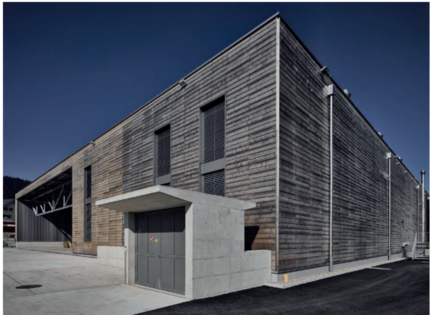
Erweiterungsbau: Die B. Braun Medical AG verdoppelte in Escholzmatt/Schweiz ihre Produktionskapazität mit einem Neubau auf dem bestehenden Areal (© IE Plast)
