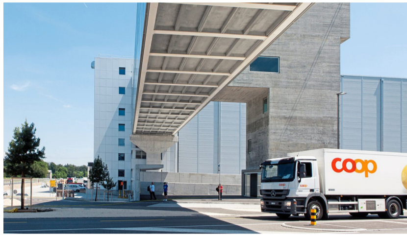
Verbindung: Eine 162 m lange „Passerelle“ dient als Brücke zwischen den Gebäuden.
